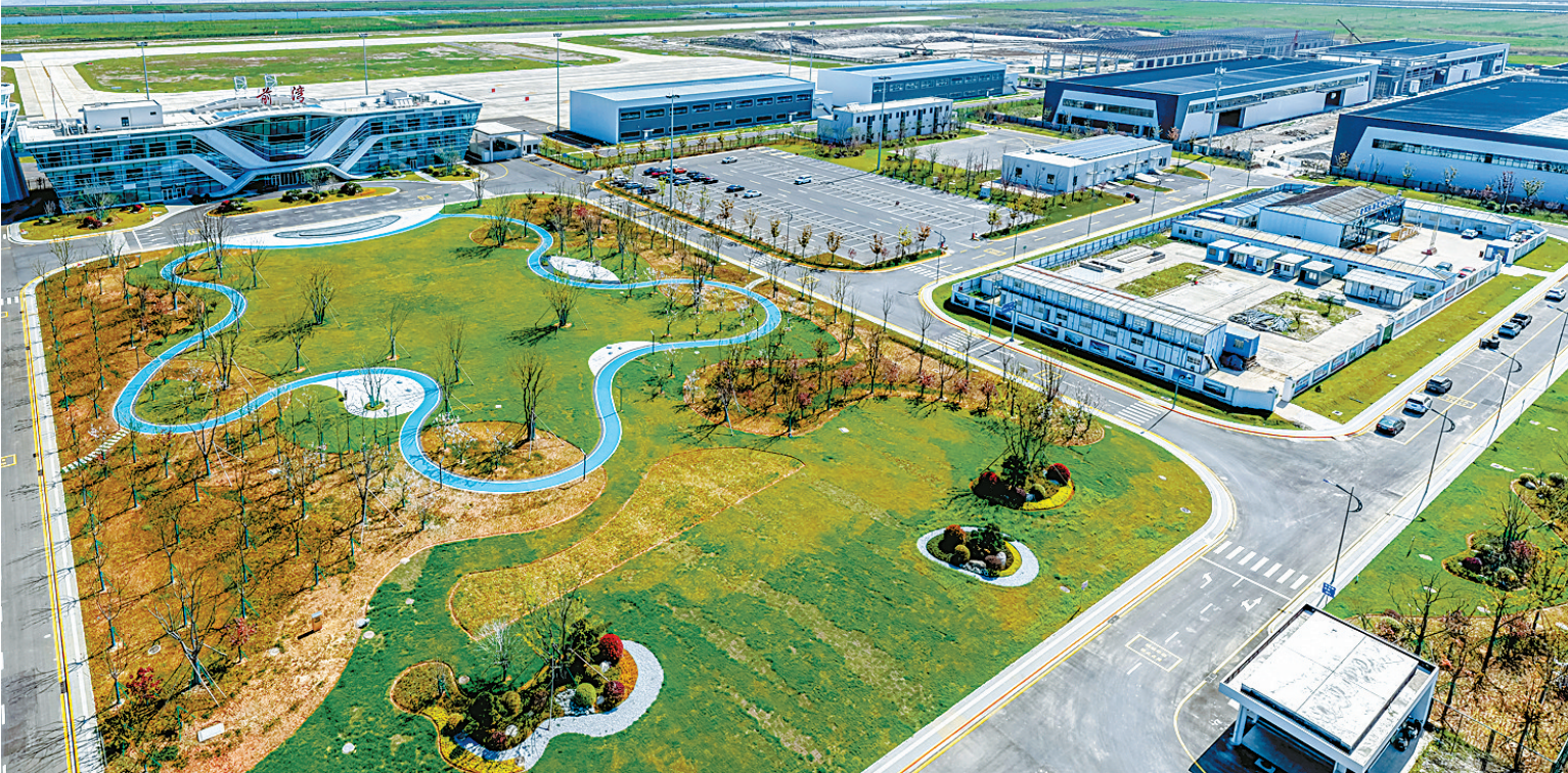
建设中的宁波前湾机场。(徐能 卓松磊 摄)
