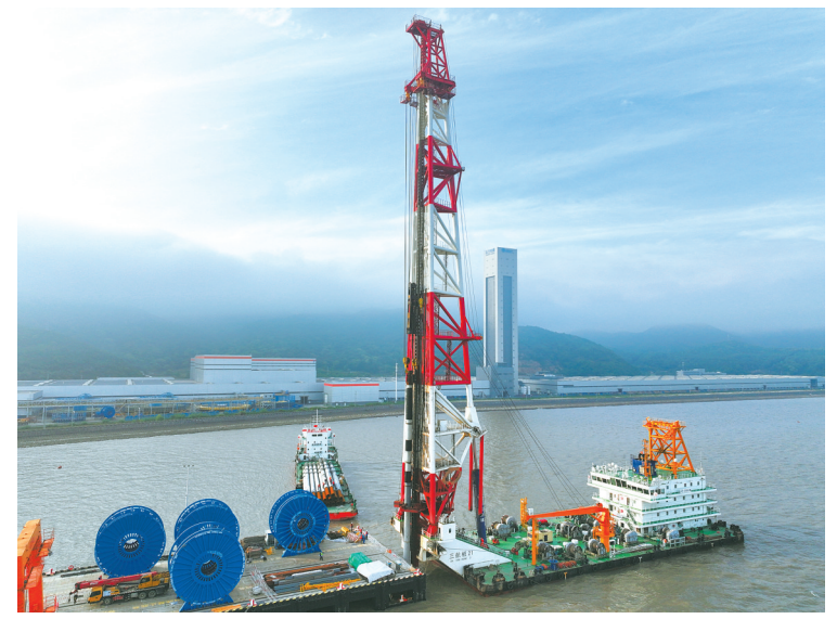
首桩沉桩现场。
