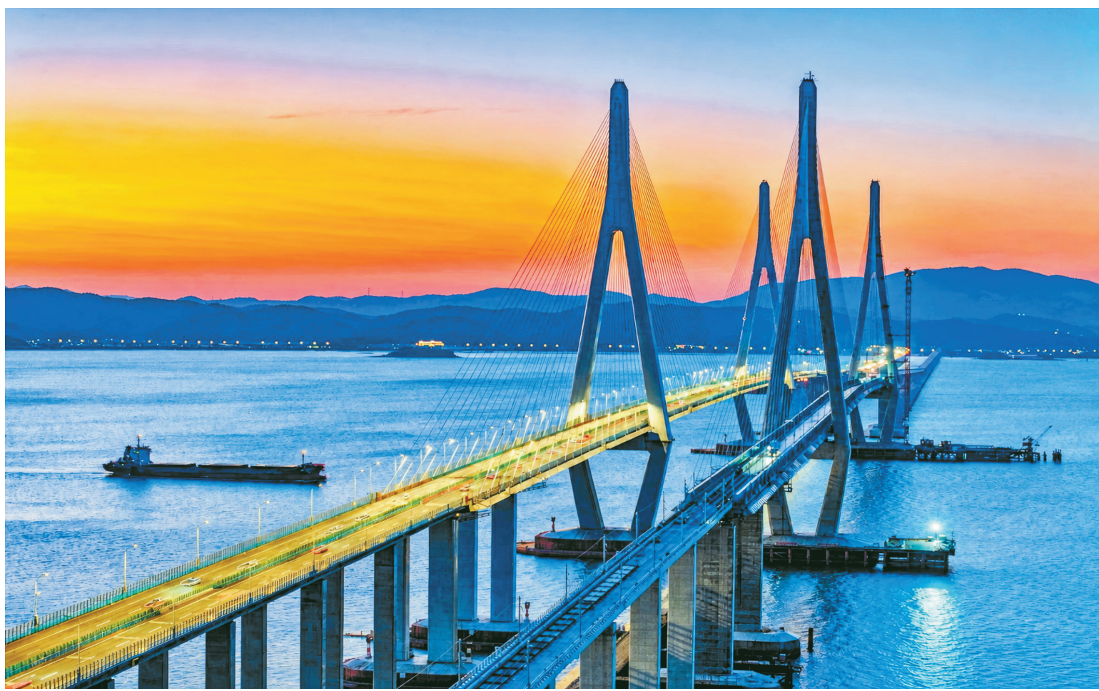
交通畅行,基础设施建设要先行。图为建设中的宁波轨道交通12号线(象山线)与象山跨海大桥(左)凌空并峙,犹如两道长虹横跨海面。(徐能 沈颖俊 摄)
