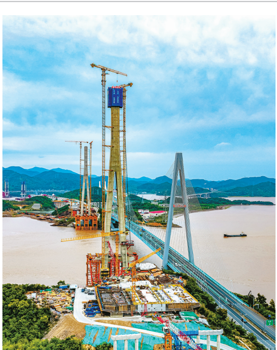
甬舟铁路桃夭门公铁两用大桥5号主塔封顶。(唐严 姚峰 祁春寒 摄)
