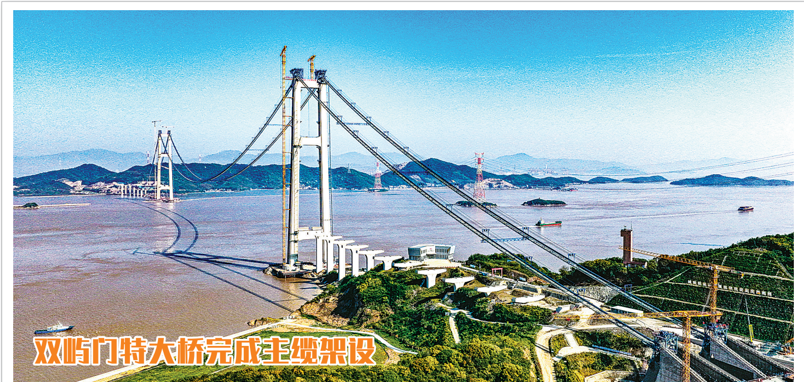
5月1日，阳光映照下的宁波舟山港六横公路大桥二期双屿门特大桥气势恢宏。随着最后一根索股精准完成调校，大桥主缆架设工作圆满收官。双屿门特大桥是目前世界最大跨度单跨吊钢箱梁悬索桥，主跨1768米，由中国铁建大桥局、中国铁建港航局联合承建。（唐严 姚峰 摄）
