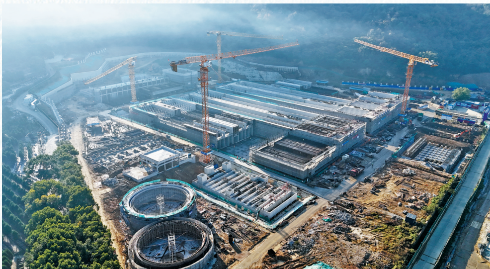
清晨，第二工业水厂建设一景。
