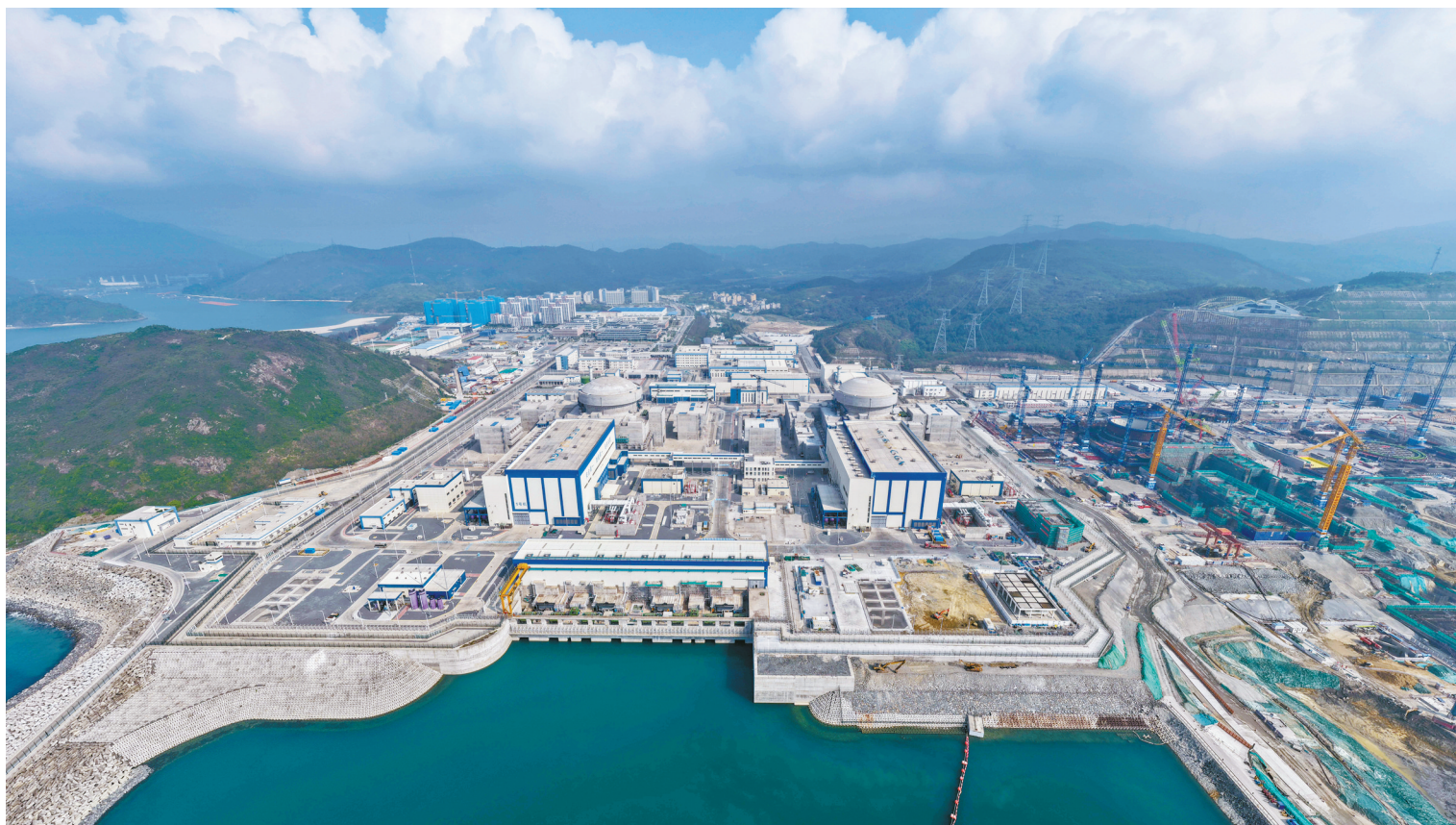
这是4月20日拍摄的中广核广东太平岭核电项目（无人机照片）。
