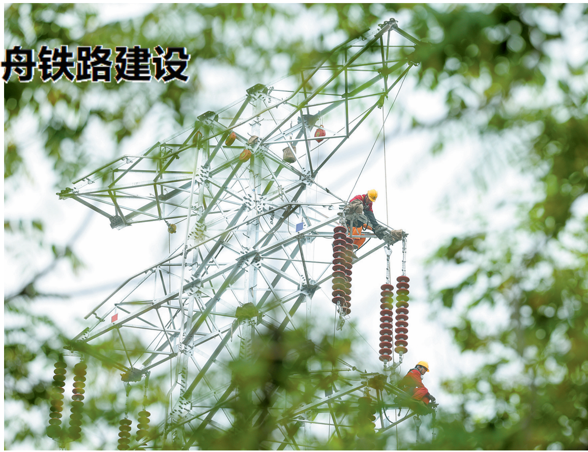
电力工人在110千伏南山线架线作业。
