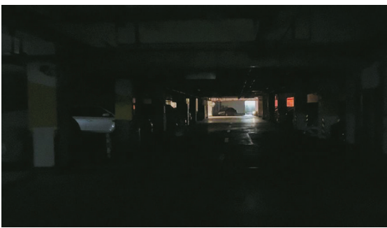
触发火警警报后应急照明未能亮起。
