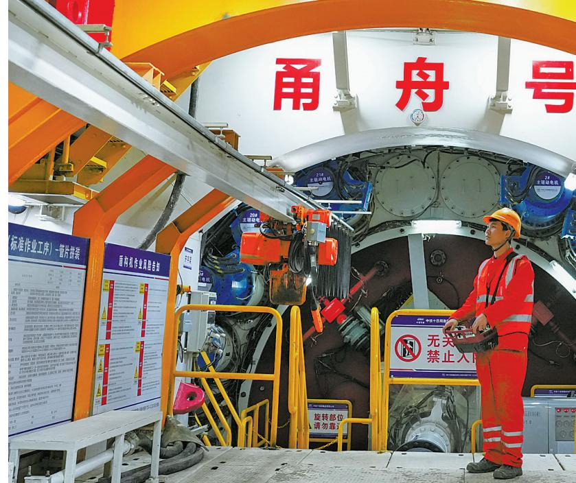
2月11日，中铁十四局技术人员在甬舟铁路金塘海底隧道“甬舟号”盾构机内配合管片拼装作业。甬舟铁路金塘海底隧道西起宁波北仑区，东至舟山金塘镇，全长16.18公里，是世界最长海底高铁隧道。目前，“甬舟号”盾构机已累计掘进超过3146米，完成了宁波侧总任务量的六成以上。（黄宗治 摄）
