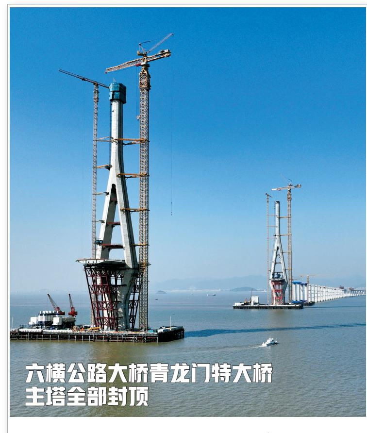
前日,六横公路大桥关键控制性工程——青龙门特大桥Q4主塔成功封顶。至此,青龙门特大桥三座主塔全部实现封顶,标志着这座目前世界跨度最大的三塔钢箱梁斜拉桥,已顺利完成下部结构施工,全面转入桥梁上部钢箱梁架设及斜拉索安装的关键阶段。
