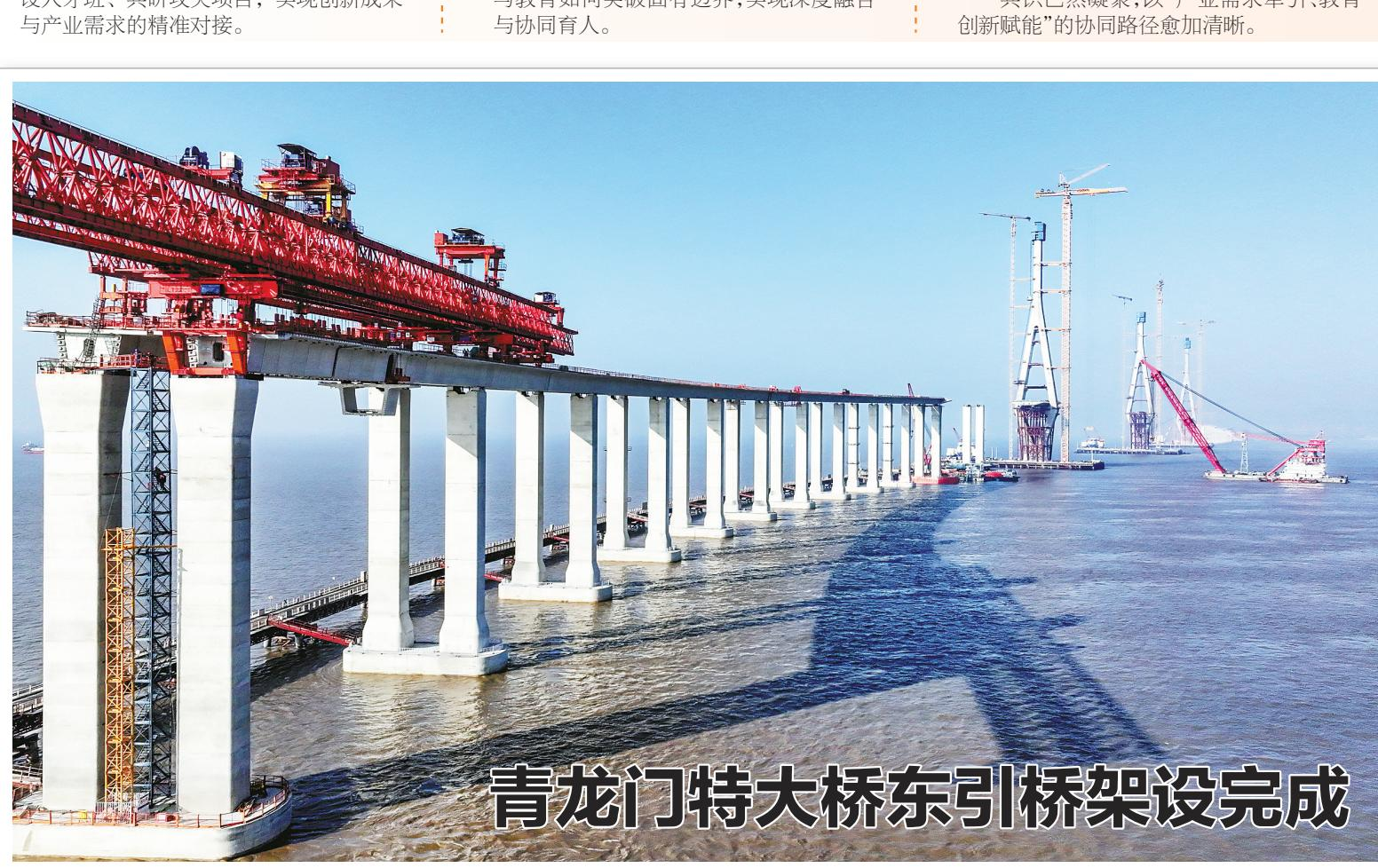
前天,记者从宁波舟山港六横公路大桥二期工程项目部了解到,青龙门特大桥东引桥436幅梁架设任务全部完成,标志着该桥主体结构施工取得突破性
