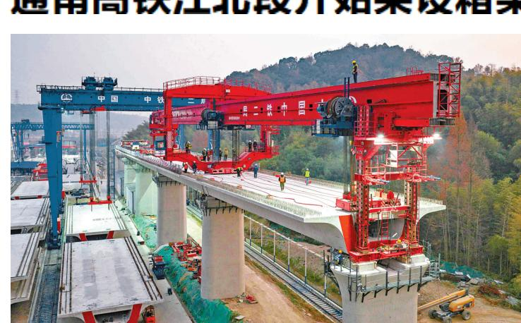
昨天，一孔长32米、重达760吨的预制箱梁被一台巨型架桥机精准、平稳地安放在桥墩上，标志着由中铁二局承建的通苏嘉甬铁路项目江北段正式拉开架梁序幕，为后续桥面施工和铺轨作业打通关键通道。
