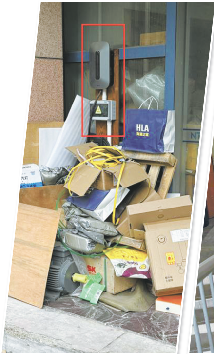
在鄞州区新天地商务大厦外，汽车充电桩和电线被“埋”在易燃杂物堆中。（仇龙杰 摄）
