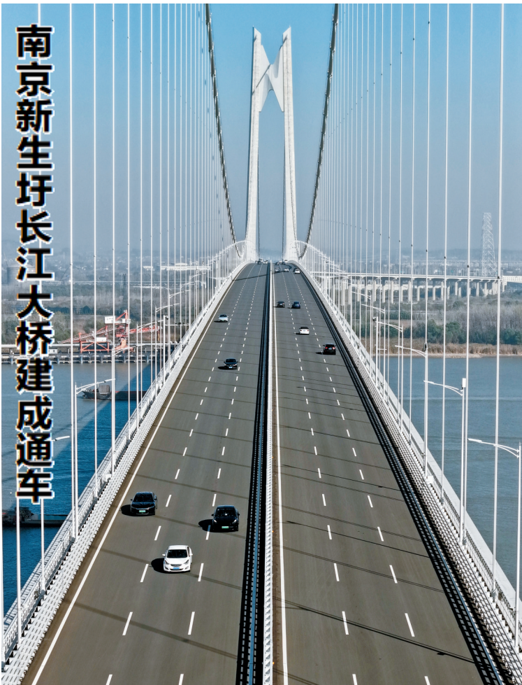
南京新生圩长江大桥建成通车。南京新生圩长江大桥是南京主城连接江北新区的重要枢纽，项目全长约13.17公里，主线设计时速80公里，双向六车道。（新华社记者 毛俊 摄）
