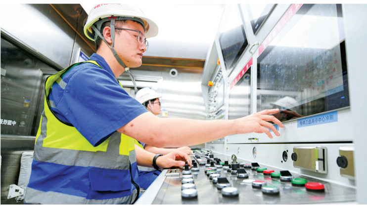
技术员在位于地下的驾驶室操作“甬舟号”盾构机。(王嘉彬 摄)
