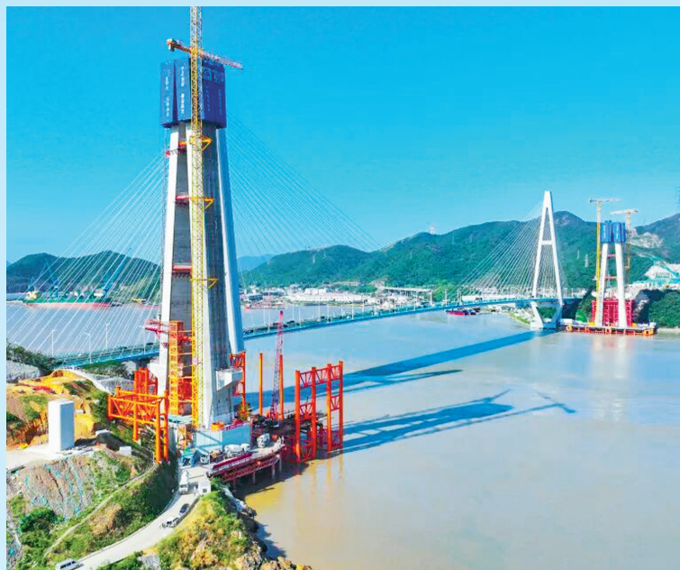
建设中的桃夭门公铁两用大桥。
