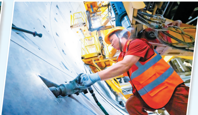
甬舟铁路金塘海底高铁隧道内部施工现场。
