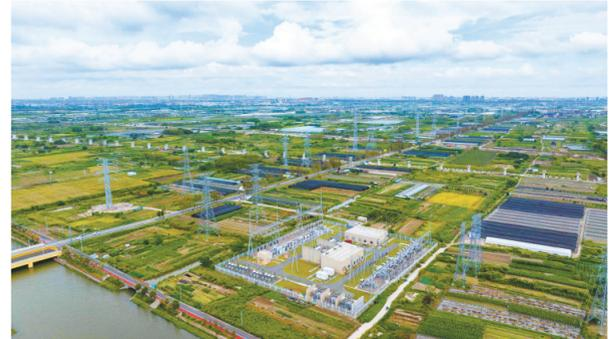
近日,随着220千伏陆崇线、陆寿线顺利投运,历时9个多月的通苏嘉甬高铁电力迁改工程慈溪段电气施工全部完成。此次慈溪片区电力迁改共涉及4回220千伏线路和10回110千伏线路。累计新建杆塔54基,新建架空线路折合单回路110.59公里;拆除杆塔32基,拆除架空线路折合单回路67.77公里。
