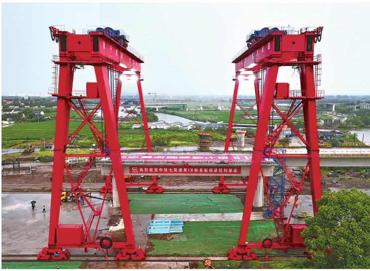
通苏嘉甬高铁施工现场。
