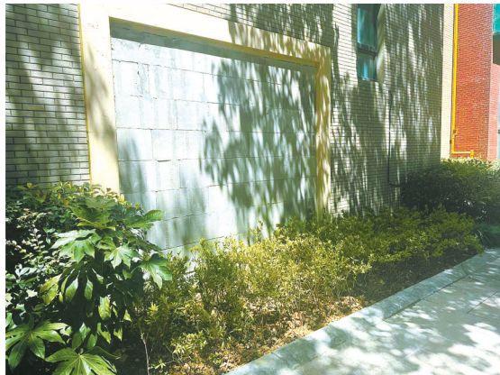
8月7日，门洞前的水泥地已被拆除，并补种了绿植。
