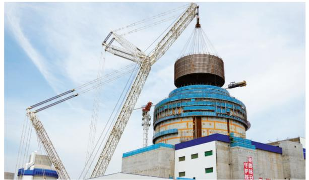
这是8月4日拍摄的山东海阳核电3号机组核岛CB20模块吊装现场。
