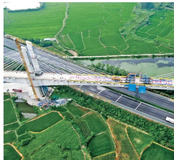
7月28日,由中国铁建大桥局承建的新建沪宁合高铁安徽段重难点工程——跨沪陕高速公路特大桥主桥顺利合龙(无人机照片)。
