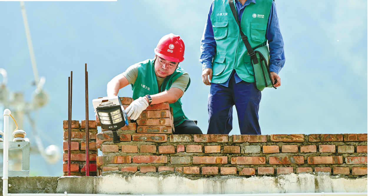
安装光伏路灯。
