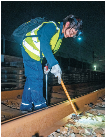
陈紫阳用检查锤敲击轨道。 (沈天舟 摄)
