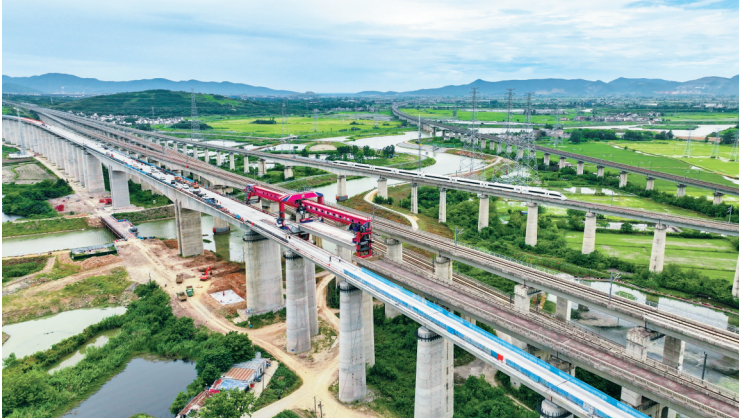
中铁四局施工机械在巢马城际铁路最后一榀箱梁架设现场作业（7月8日摄，无人机照片）。
