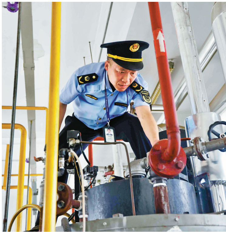
执法人员正在检查锅炉安全情况。（许天长 摄）
