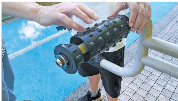
云丰公园内压腿器的按摩套筒固定螺丝已松动脱落。
