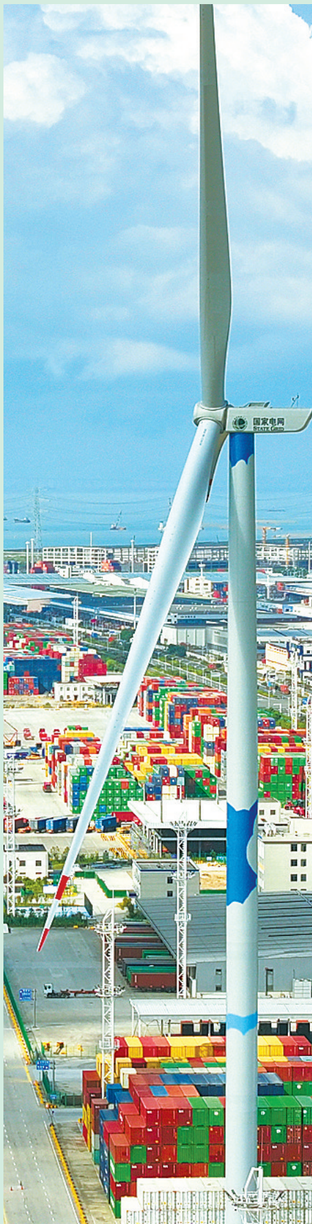
国家电网宁波舟山港风光储一体化锂电码头。
