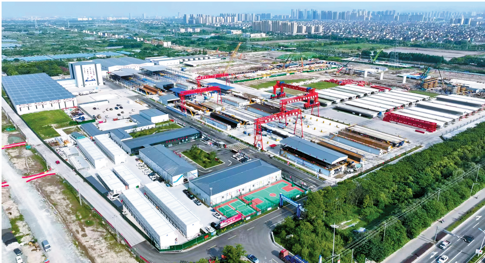
慈溪制梁场与远处的通苏嘉甬高铁施工现场。
