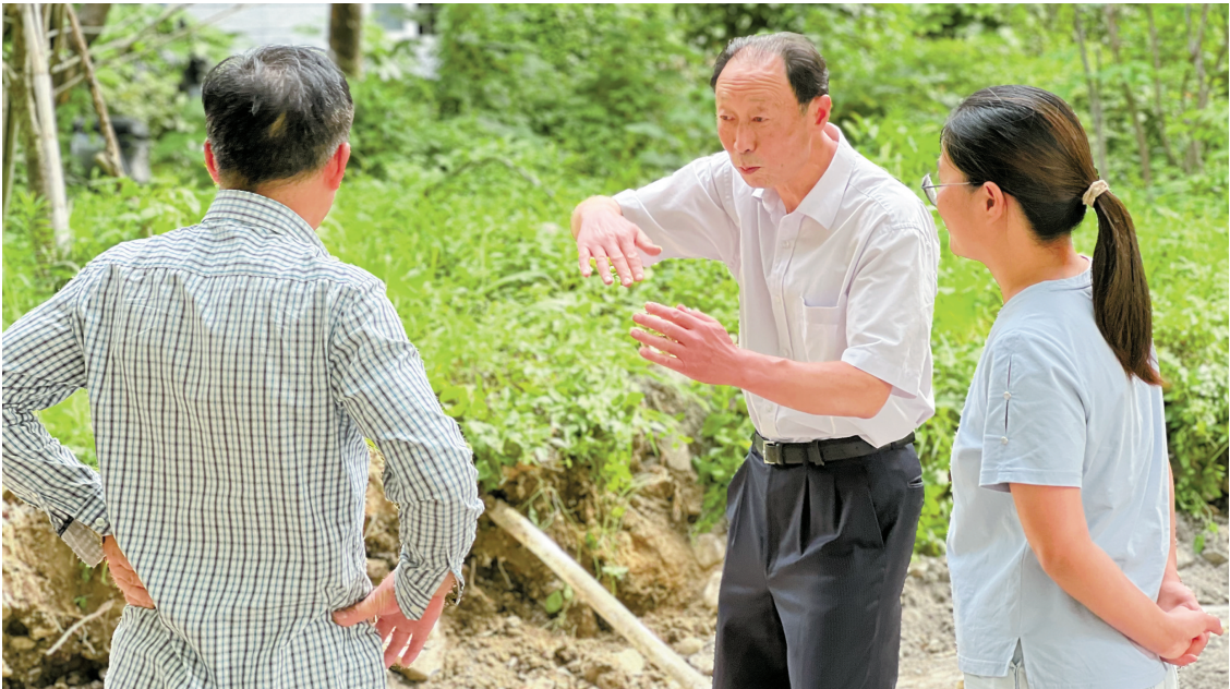
季闽浦（中）在施工现场。
