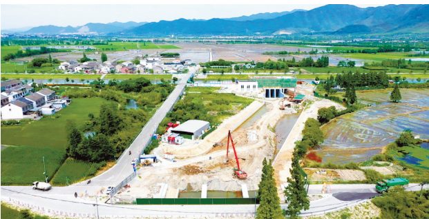
建设中的奉化区王家汇泵站。（孙吉晶 陈飒 摄）
