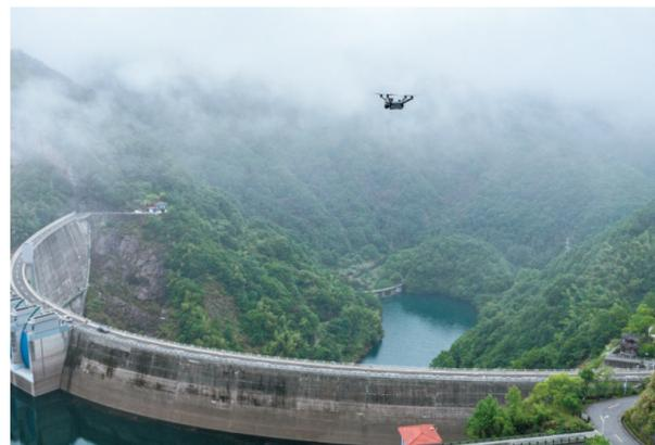
前天上午，随着两架无人机分别从周公宅水库和皎口水库智能机库腾空而起，周一皎水库无人机智能巡查系统正式投入运行，这是全省首个投用的梯级水库空地一体智能巡查系统。据了解，该无人机会根据设定的时间和路线自动完成起降及巡查。实时回传的图像和数据通过AI算法智能识别和测算，能够监测大坝裂缝、渗漏等安全隐患，也能发现库区内游泳、钓鱼等违规行为。当发现异常事件时，系统可在20秒内完成立案并将预警信息推送到工作人员手机中。这一系统的投用标志着我市水利工程安全监管迈入“数字孪生+低空经济”融合发展的新阶段，该系统也将在防汛工作中发挥重要作用。（孙吉晶 沈天舟 张小飞 摄）
