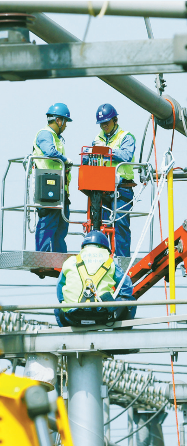
500千伏河姆变电站综合检修工程现场。（王幕宾 摄）
