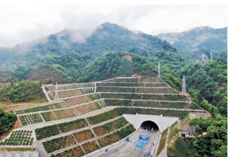
5月13日拍摄的西康高铁秦岭九天山隧道（无人机照片）。5月13日，由西成客专陕西公司建设、中铁七局承建的西康高铁秦岭九天山隧道顺利贯通，这标志着西康高铁全线20座隧道全部贯通。穿越秦岭山脉的西康高铁，新建正线全长171公里，设计时速350公里。建成通车后将大幅缩短关中城市群与陕南秦巴山区的时空距离，方便沿线居民出行，对陕南秦巴山区乡村振兴具有重要意义。（新华社发）
