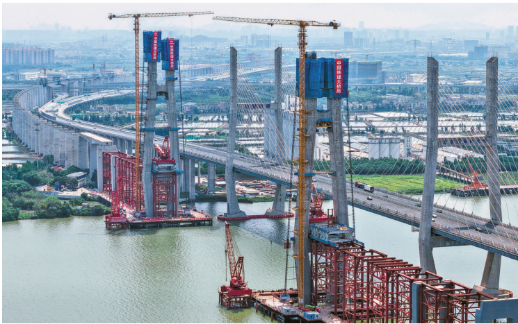
5月11日，深江铁路跨磨刀门水道主桥东主塔(左一)封顶(无人机照片)。该桥横跨中山和江门两市交界的西江磨刀门水道，为140米高墩大跨斜拉桥。该工程建成后，深圳与江门可实现1小时内通达。（新华社发）
