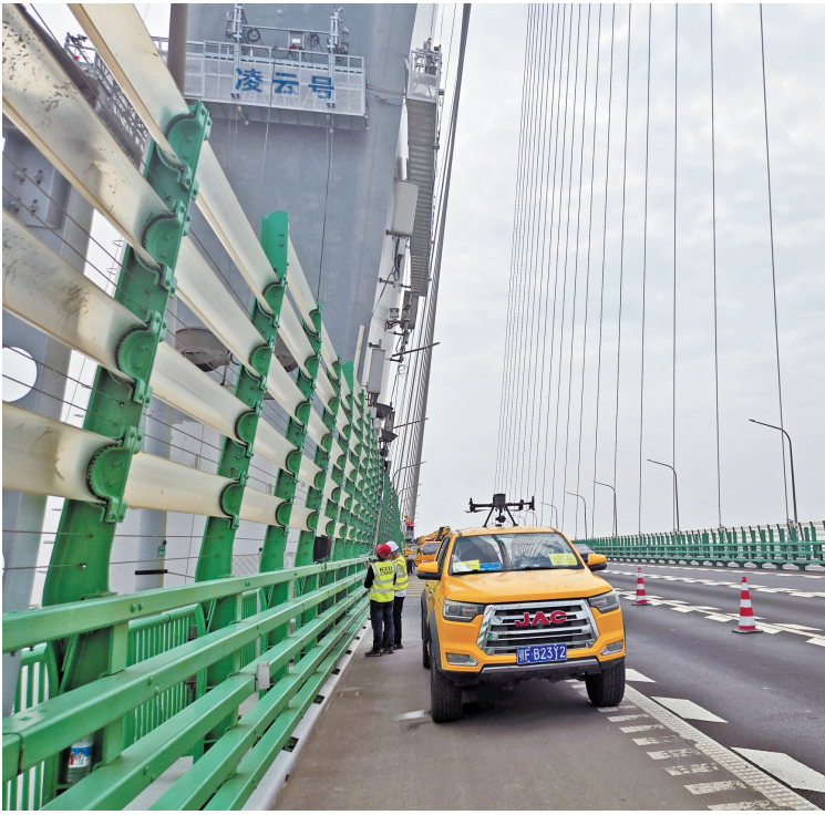
工作人员使用无人机巡检大桥。（金鹭 余明霞 摄）
