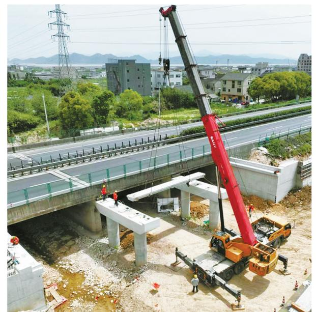
前日，随着首片预制梁板平稳精准地落在张家庄小桥右桥墩盖梁上，甬台温高速改扩建宁波南段TJ-2标项目进入上部结构施工阶段。（孙佳骏 何明芳/文 浙江交通集团供图）
