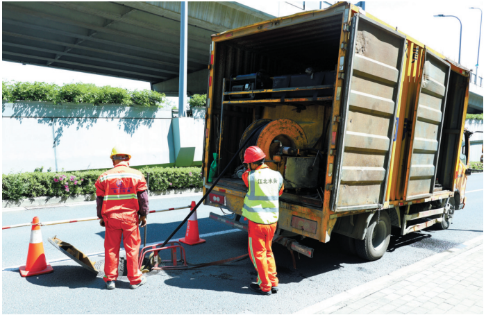
工作人员正在疏通排水管网。（戎美容 摄）
