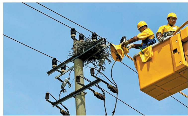
带电作业人员对带电设备安装绝缘遮蔽装置。(通讯员供图)
