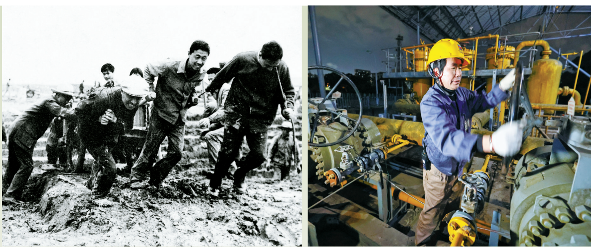
镇海发电厂一期工程主厂房土方开挖。 (张关兴 摄)
