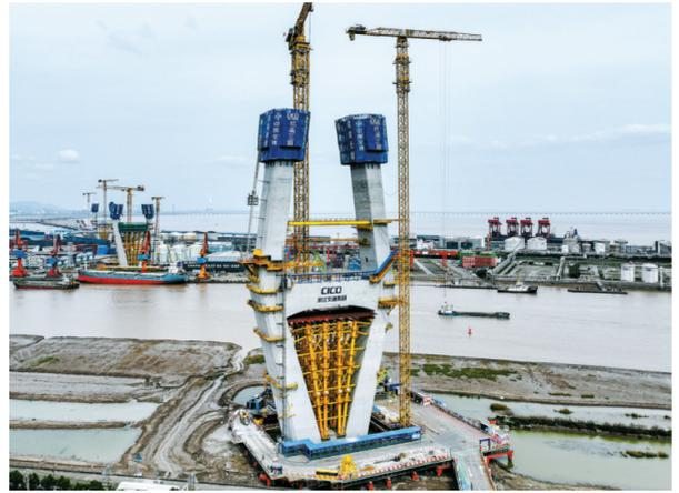
近日，杭甬复线宁波三期项目甬江特大桥主塔建设如火如荼，工人在百米高空进行施工。据了解，甬江特大桥设计为主跨540米+570米三塔方案，塔身采用大倾角钻石型结构，由下塔柱、中塔柱、塔冠、下横梁组成，最高达223米，该桥梁是目前世界上最大跨径的不对称三塔斜拉桥。据悉，60号索塔施工高度已超百米，为后续主塔封顶及钢梁架设奠定了坚实基础。（唐严 姚峰 陈芊 摄）
