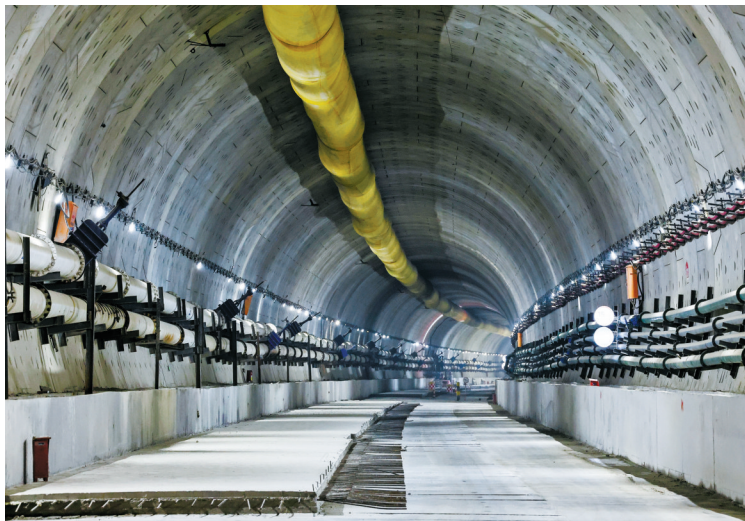
汕汕高铁汕头湾海底隧道盾构贯通段(3月26日摄)。
