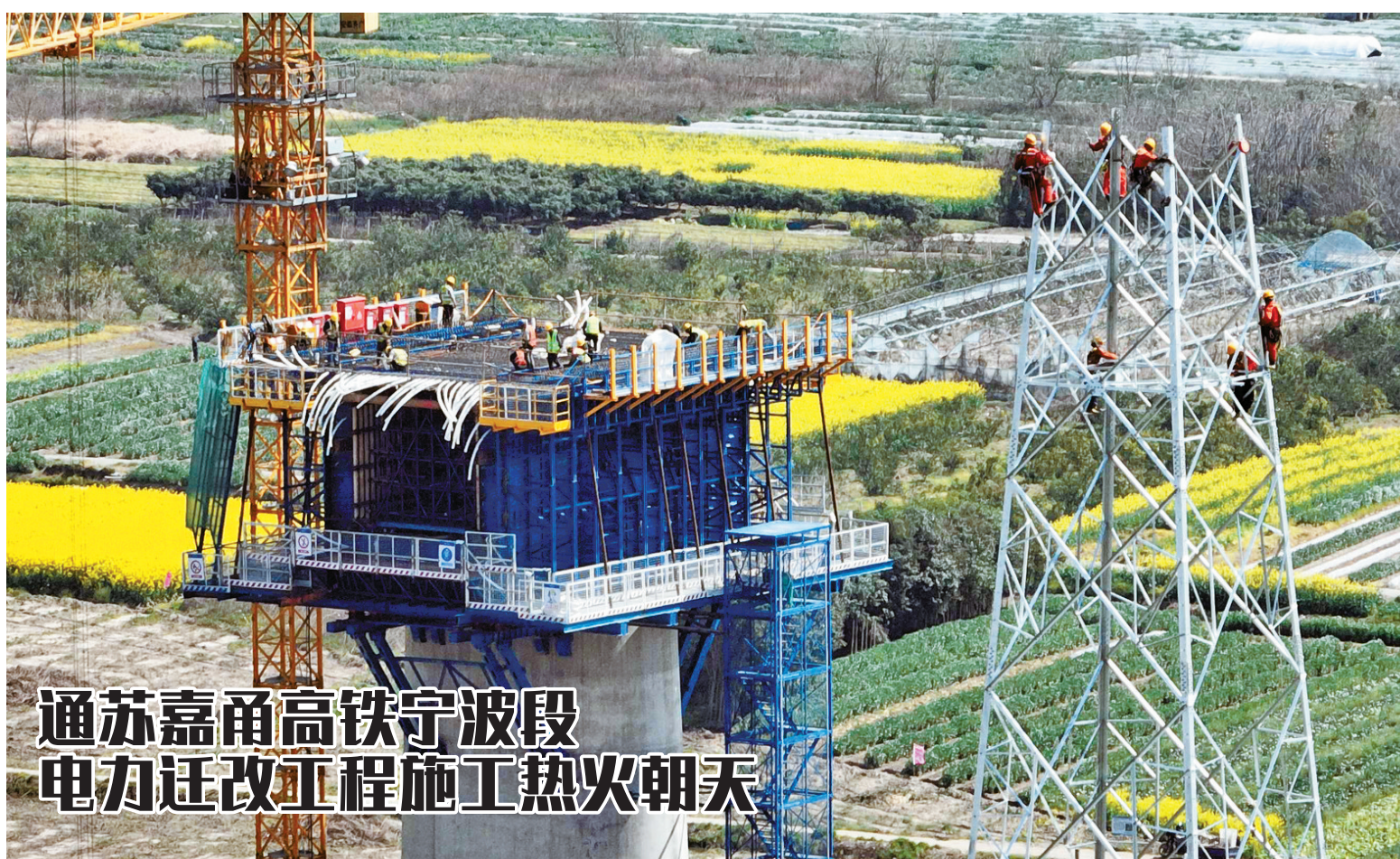
随着项目建设的不断推进，通苏嘉甬高铁宁波段110千伏及以上电力迁改工程已全面进入电气施工阶段。
