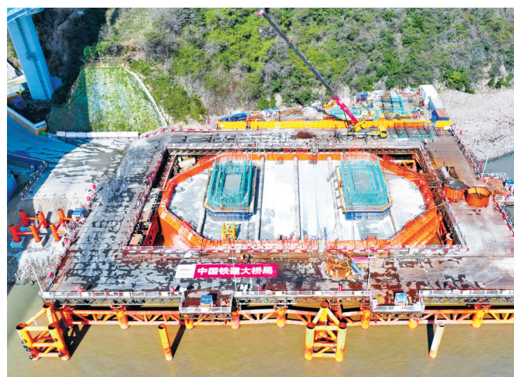
桃天门公铁两用大桥施工现场。(通讯员供图)
