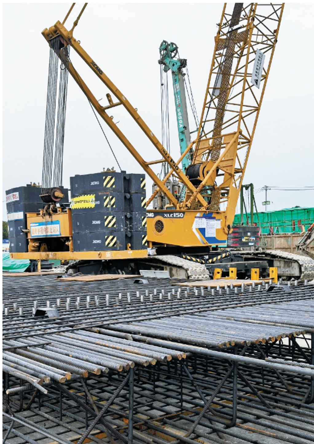
1#张俞变始发井施工现场。（受访者供图）
