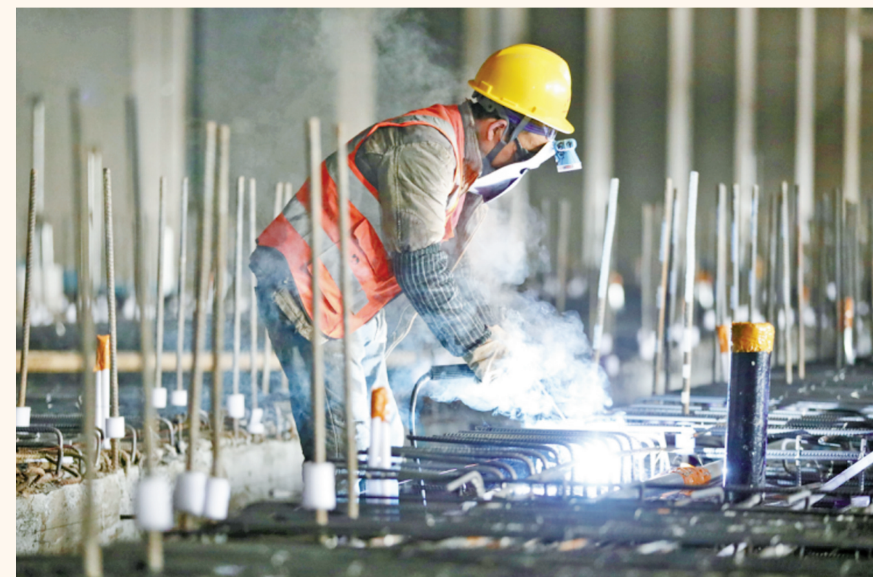
轨道交通施工现场，一名工人正在焊接钢筋。（徐诚 摄）
