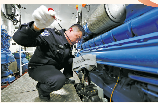
吕良羽对船艇进行检修。(通讯员供图)
