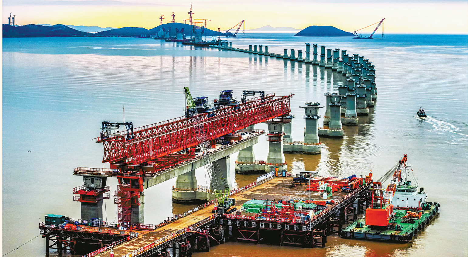
春节假期不停歇。前天清晨，在宁波舟山港六横公路大桥二期工程的重要组成部分——青龙门特大桥西引桥建设现场，中国铁建港航局的施工人员开始了紧张而有序的阶段梁湿接缝工作。青龙门特大桥西引桥为70米跨径非通航孔桥，全长2870米，共设8联41跨82孔，需架设1788榀阶段梁，计划于2026年底前完成。
