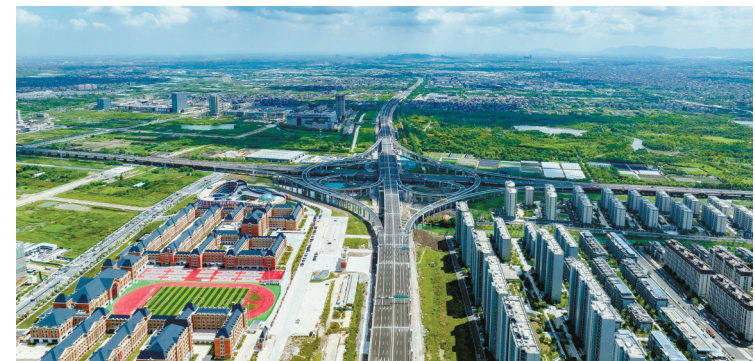
中横线快速路一期高架道路。
