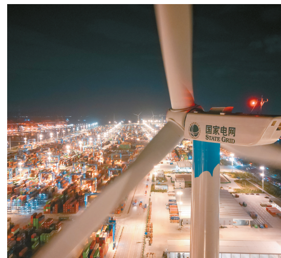
浙江省首个“绿电码头”——国家电网宁波舟山风光储一体化示范工程投运。(张晋豪 摄)
