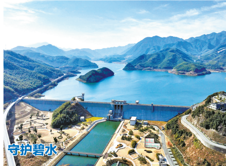
春节临近，为确保节日期间我市供水水平，市水务环境集团提前采取了一系列预防措施。针对冬季寒冷天气，该集团对辖区所有水厂设备进行了全面的防冻保温处理，并加大了对管网、阀门等关键供水设施的巡视和维护力度，保证管网运行畅通。图为葛岙水库。（戎美容 唐严 摄）
